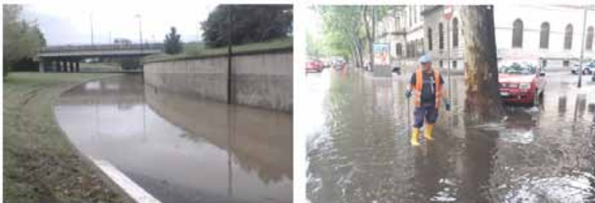
Figura 25 – Strade allagate a Torino. Fonte: SMAT S.p.A.
