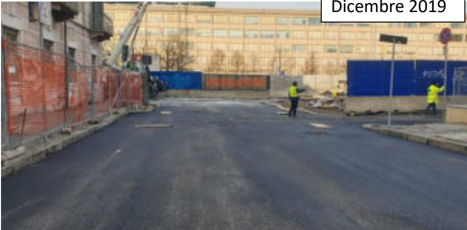
Apertura di Via Vado
