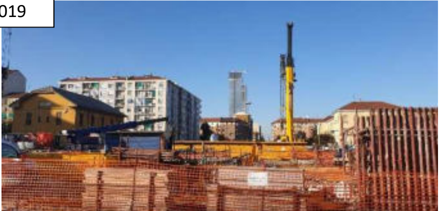
Smontaggio del carro ponte in piazza Bengasi
