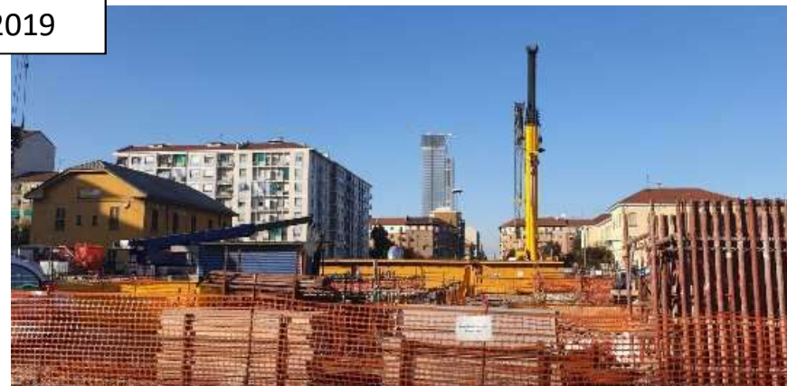
Smontaggio del carro ponte in piazza Bengasi
