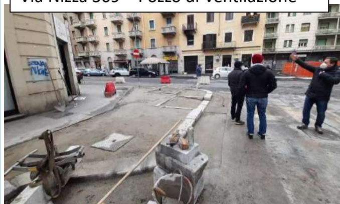
Via Nizza 369 – Pozzo di Ventilazione
